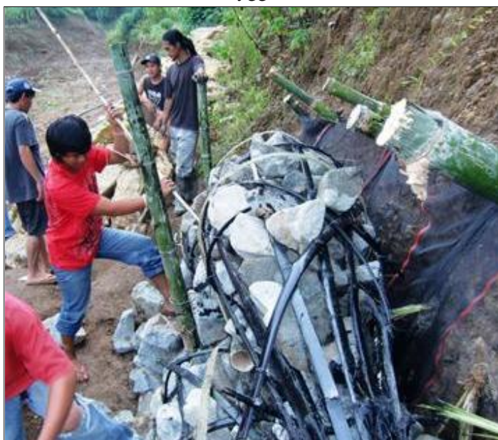
Förstärkning av vägbank som riskerar att eroderas vid översvämning. Korgen (gabion) består av splittrad bambu.
