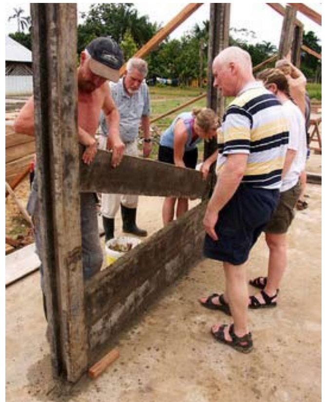
3. Betongplanken träs in mellan stolparna.
