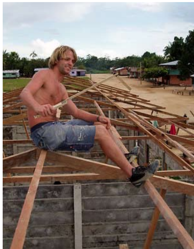
6. Takstolarna monteras.
